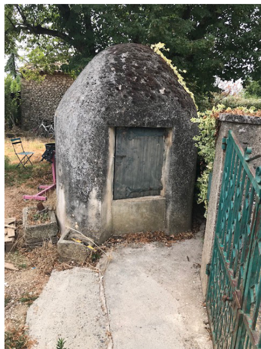
Le puits des Marchands
